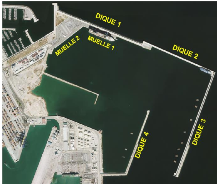
Figura nº3: Estado actual de las obras
