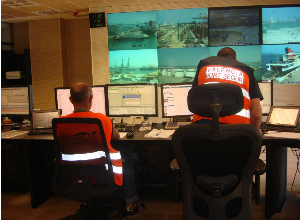
Instalaciones del Centro de Control de Emergencias de la Autoridad Portuaria de Valencia
