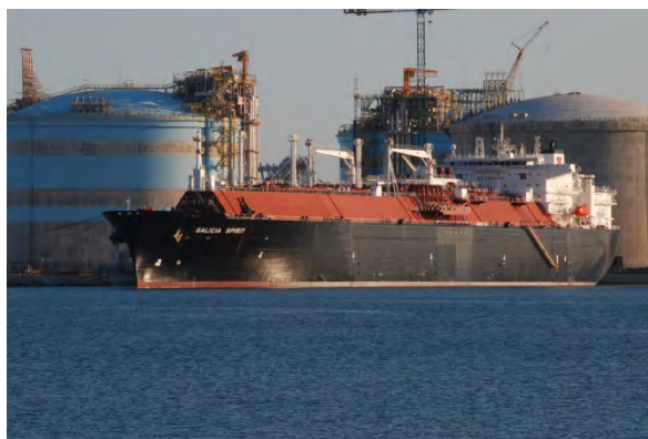
Buque gasero con tanques de sistema de membrana
