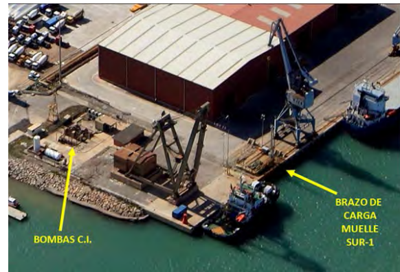
Instalación de descarga de FERTIBERIA en Muelle Norte-1 del Puerto de Sagunto.
