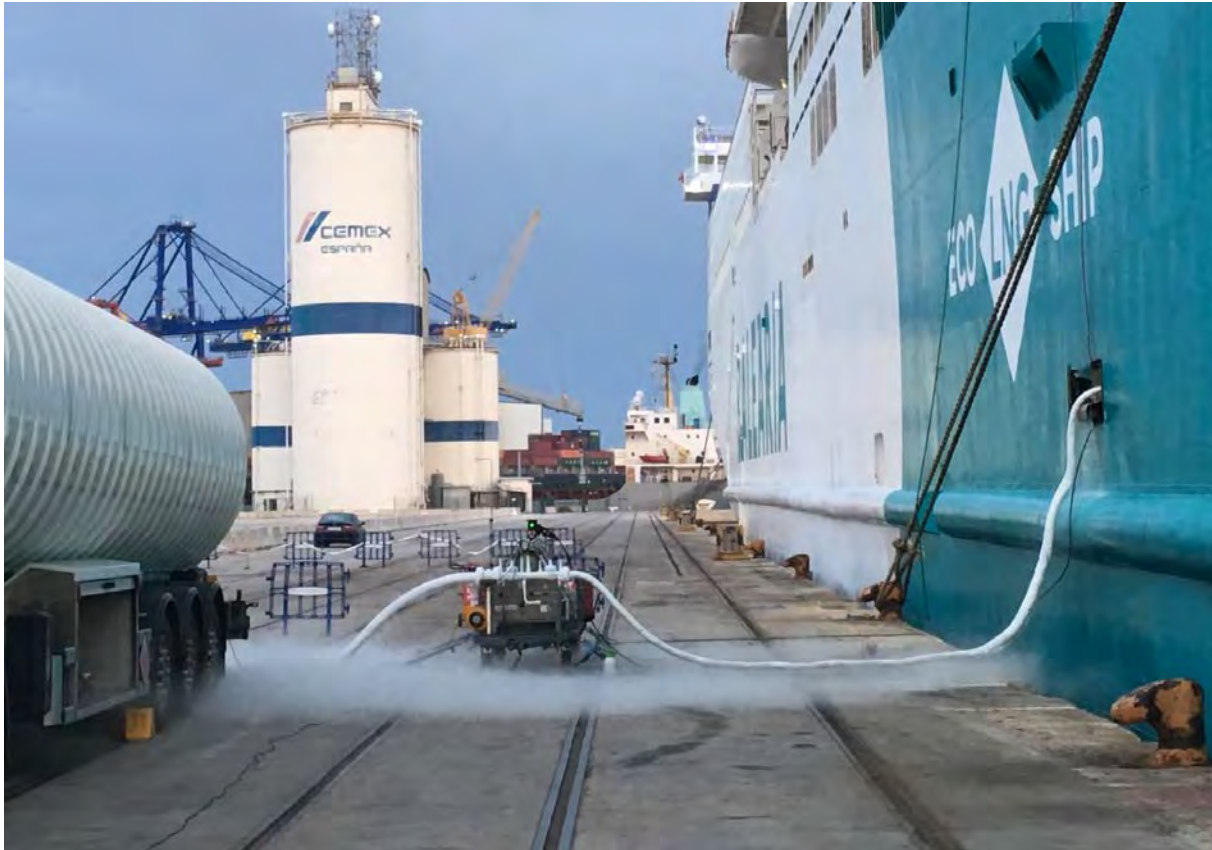
Imagen de suministro TTS de GNL a buque
