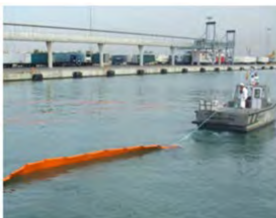
275 m. de barrera de flotadores planos.
