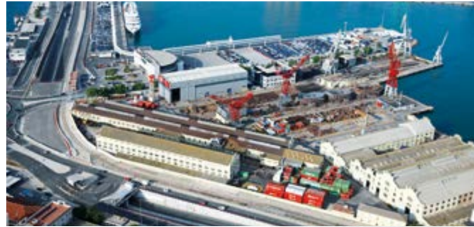
La Autoridad Portuaria está trabajando en el proyecto de construcción de una terminal definitiva dentro de aproximadamente tres años.
