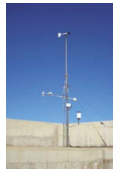
Estación Meteorológica Dique Este Sagunto
