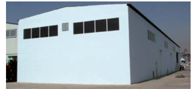
Instalaciones del CTR.
