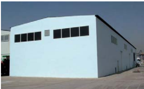
Instalaciones del CTR.
