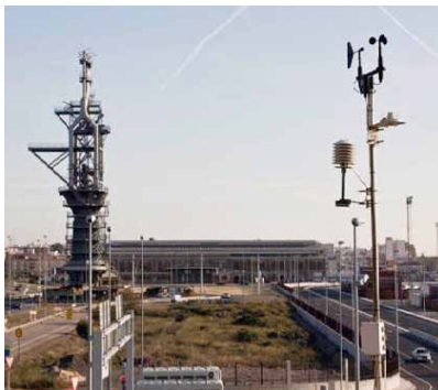
Estación Meteorológica Oficinas Sagunto
