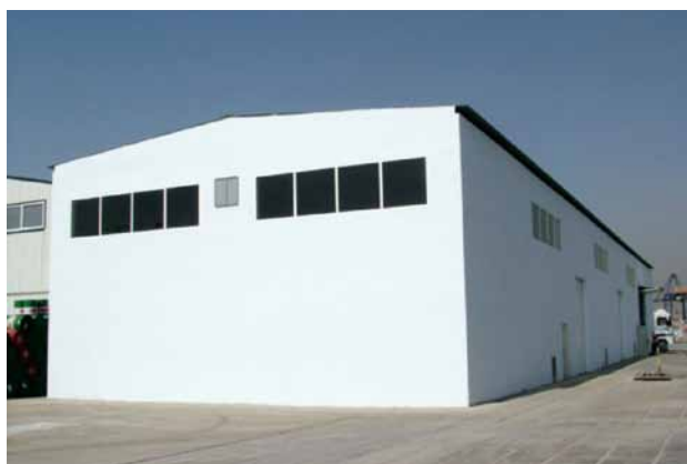
Instalaciones del CTR
