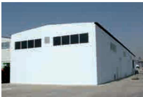
Instalaciones del CTR
