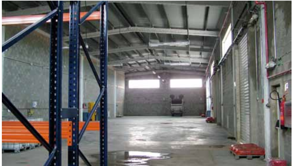
Instalaciones del CTR
