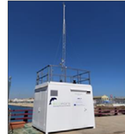
Poniente Transversal Quay AQMS
