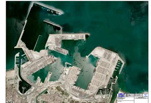
Fotografía en planta
