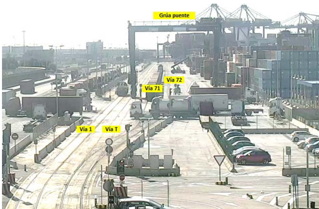
Vista de la playa de vías de la Terminal del Muelle de Levante, tomada con dirección a Valencia Puerto Norte, en la que se aprecia la distribución de las vías y la posición de la grúa puente operando sobre la vía T.
