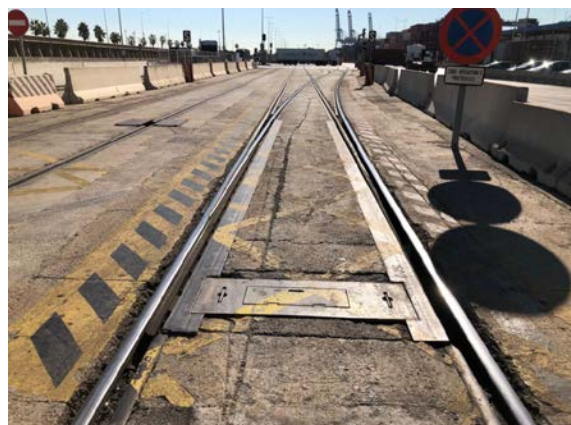
Vista del desvío nº 25, tomada con dirección Valencia Puerto Norte
