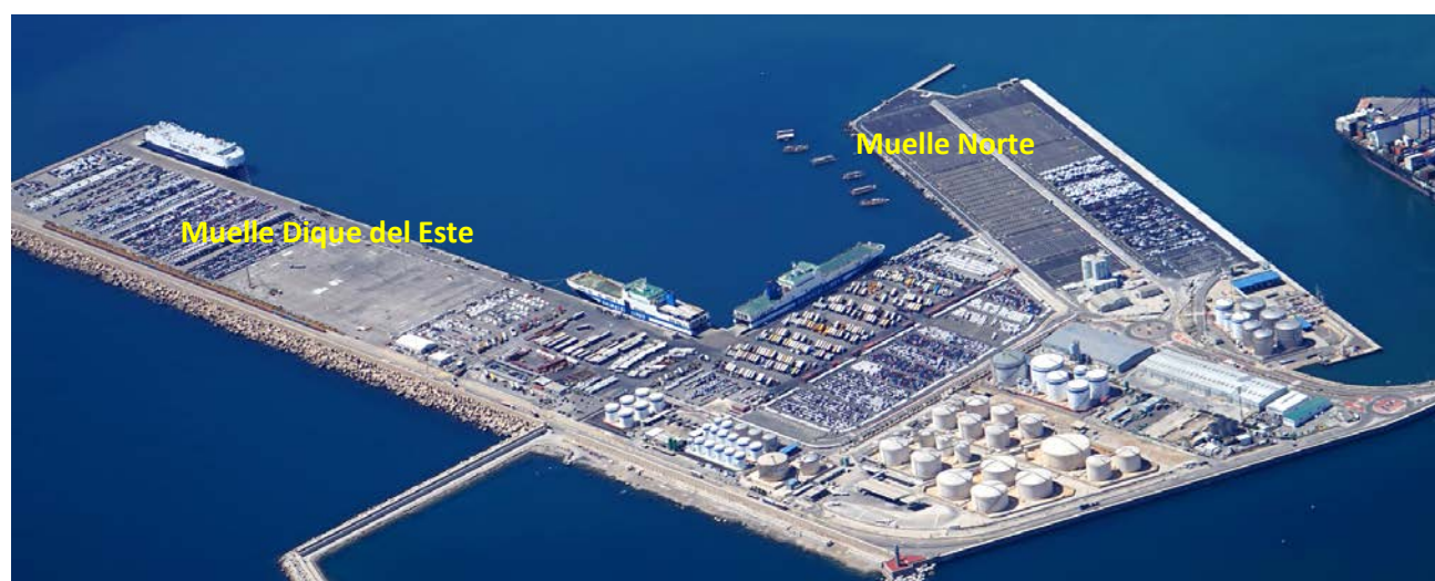
Imagen del Muelle Dique del Este.
