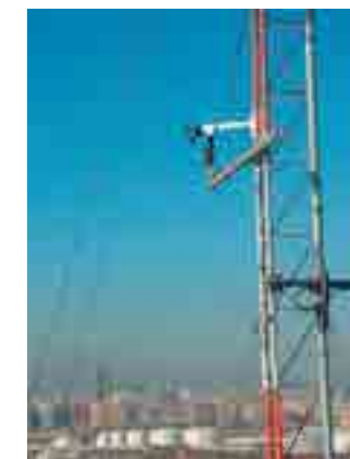
3. Estación Meteorológica Silo
