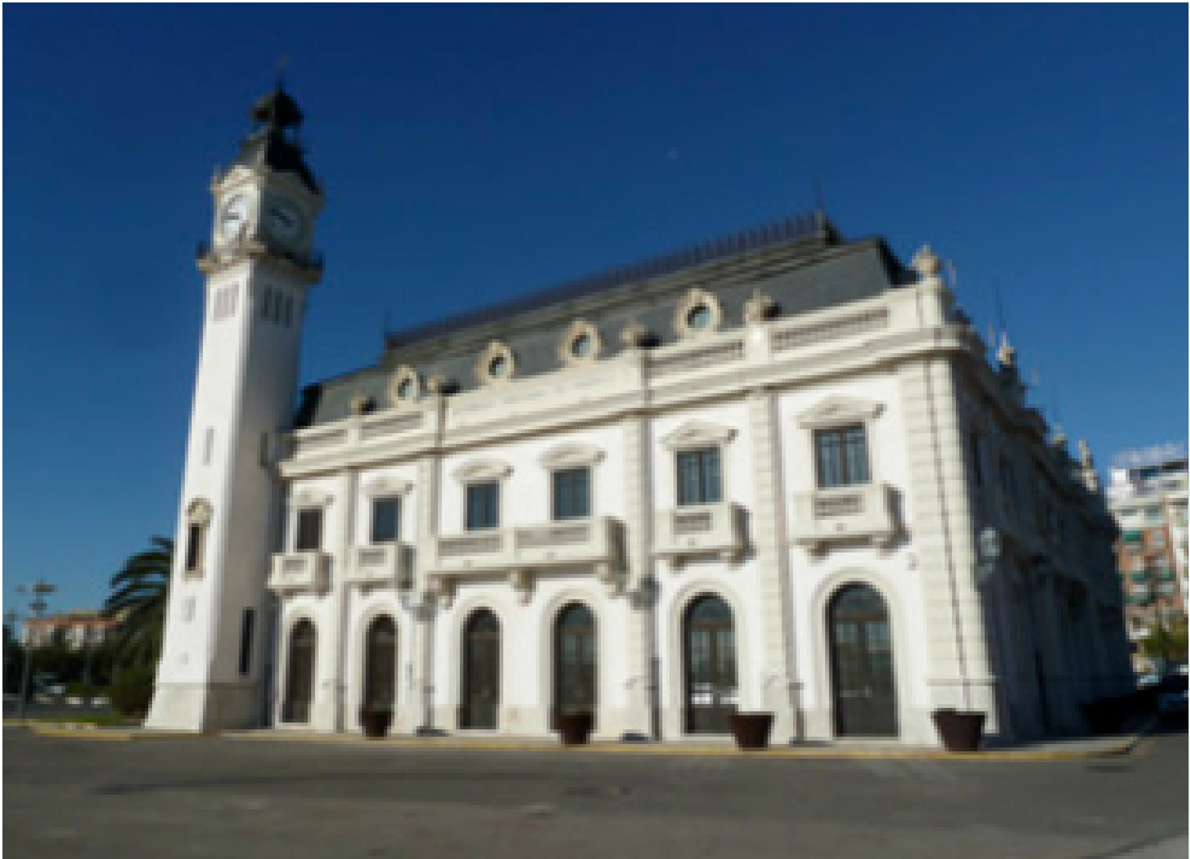
Edifici del Rellotge
