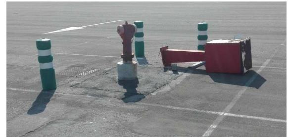
Se plantea la retirada y demolición de cualquier elemento superficial de la red de hidrantes existente que quedará anulada. Esto incluye tanto los propios hidrantes como las bases de hormigón que los soportan, también las peanas de dotación para hidrantes y cualquier otro elemento relacionado con la instalación.
