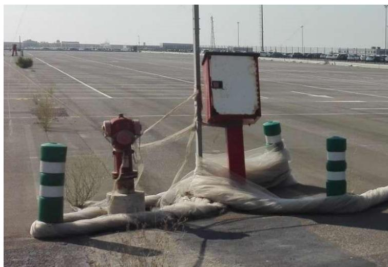
Los extintores que existen tampoco se encuentran en las condiciones adecuadas. No están colocados correctamente y no están debidamente señalizados.
