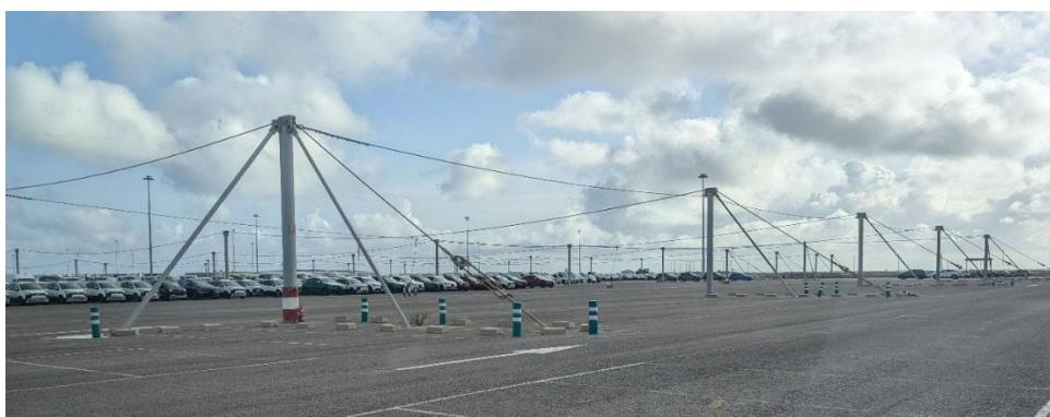
Para ello se procederá al corte perimetral de toda la superficie afectada para delimitar la demolición del pavimento, se retirarán las balizas y los bloques de bordillo para despejar la zona de trabajo y se procederá al destensado y desmontaje de los tensores. Posteriormente se procederá al corte, con los medios adecuados, de los soportes secundarios que están empotrados en el pavimento y al corte del anclaje de los tensores en el pavimento.
